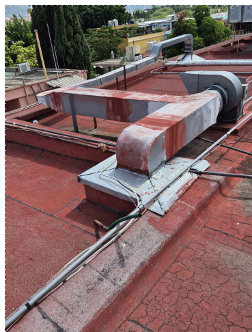
DL19. VISTA DESDE LA AZOTEA DEL TEATRO, DONDE SE APPRECIA CLARAMENTE LA DUCTERÍA DE ACERO GALVANIZADO Y LOS DOMOS DE INYECCIÓN EN LA LOSA.
