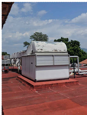
DL20. VISTA DE LA BASE PARA UNO DE LOS CONDENSADORES DE LOS DUCTOS DE AIRE ACONDICIONADO, DONDE SE OBSERVA EL IMPERMEABILIZANTE APP QUE RECUBRE LA LOSA CON PRESENCIA DE CRAQUELADO Y DESGASTE DEBIDO A LA FALTA DE MANTENIMIENTO.
