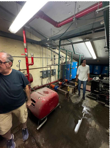
EA8. CUARTO DE MÁQUINAS BAJO LA RAMPA DE ACCESO VEHICULAR, DONDE SE OBSERVAN LOS EQUIPOS DE BOMBO Y TUBERÍAS DE ALIMENTACIÓN, PRINCIPAL, EN LA PLANTA SÓTANO DEL INMUEBLE.
