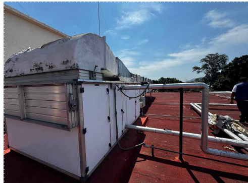
EA41. VISTA PONIENTE-ORIENTE DESDE LA AZOTEA DEL TEATRO, DONDE SE OBSERVA UNO DE LOS EQUIPOS DE AIRE ACONDICIONADO, DUCTERÍA Y EL IMPERMEABILIZANTE QUE RECUBRE TODA LA LOSA.
