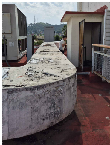
DL18. VISTA DESDE LA AZOTEA DEL TEATRO, DONDE SE OBSERVA PARTE DE LA DUCTERÍA DE ACERO GALVANIZADO RECUBIERTA CON AISLAMIENTO DE FIBRA DE VIDRIO CON PRESENCIA DE DESGARRES, FALTANTES Y DESPRENDIMIENTO DEBIDO A LA FALTA DE MANTENIMIENTO Y EXPOSICIÓN A LA INTERPERIE.
