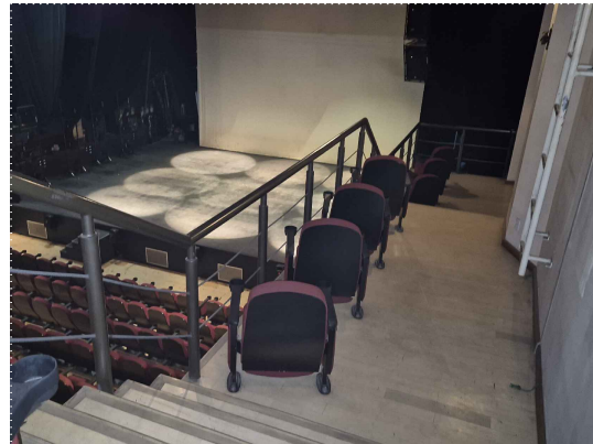
DELTA, PARTE ALTA DEL PALCO, EN EL INTERIOR DEL AUDITORIO DEL TEATRO, DONDE SE OBSERVA EL PISO VINÍLICO COLOR BEIGE DE 5MM DEL AUDITORIO CON PRESENCIA DE RAYADURAS, HOQUEADES Y DESPRENDIMIENTO, DEBIDO AL TRÁFICO CONTINUO Y LA FALTA DE MANTENIMIENTO.
