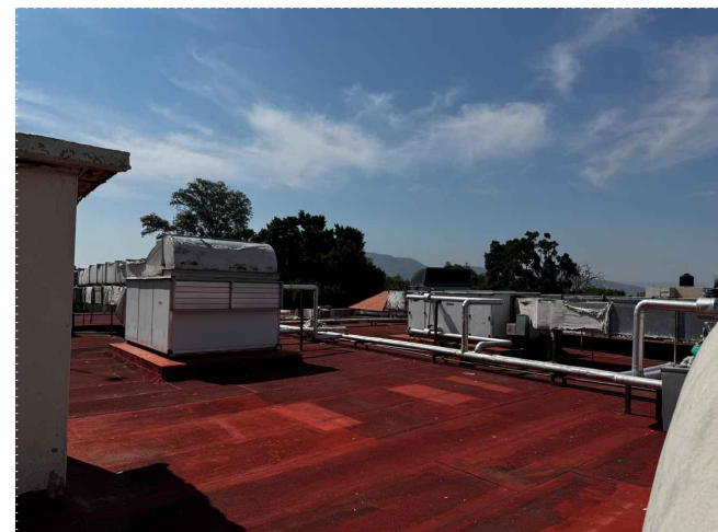
DL15. VISTA DESDE LA AZOTEA DEL TEATRO, DONDE SE OBSERVA EL IMPERMEABILIZANTE APP QUE RECUBRE LA LOSA CON PRESENCIA DE CRAQUELADO Y DESGASTE DEBIDO A LA FALTA DE MANTENIMIENTO.
