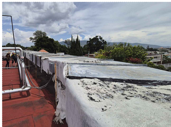
DL17. VISTA DESDE LA PARTE POSTERIOR DE LA AZOTEA DEL TEATRO, DONDE SE OBSERVA PARTE DE LA DUCTERÍA DE AIRE ACONDICIONADO DE LÁMINA GALVANIZADA CON RECUBRIMIENTO DE FIBRA DE VIDRIO CON PRESENCIA DE DESGARRES, FALTANTES Y DESPRENDIMIENTO DEBIDO A LA FALTA DE MANTENIMIENTO Y EXPOSICIÓN A LA INTERPERIE.
