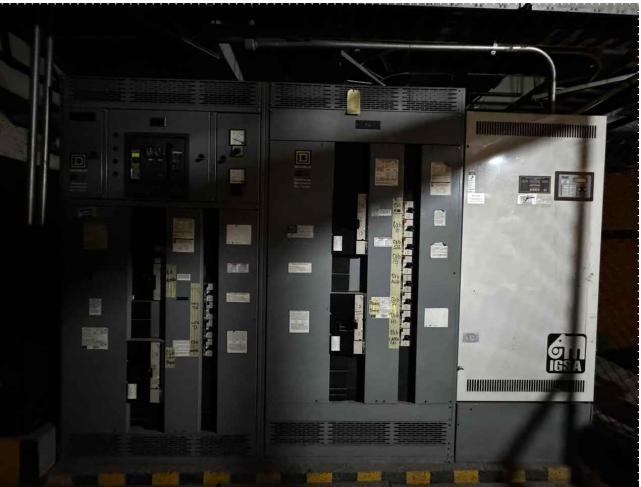
EA9. ÁREA DEL CENTRO DE CARGAS EN EL SÓTANO DEL TEATRO, DONDE SE OBSERVAN LOS TABLEROS PRINCIPALES.
