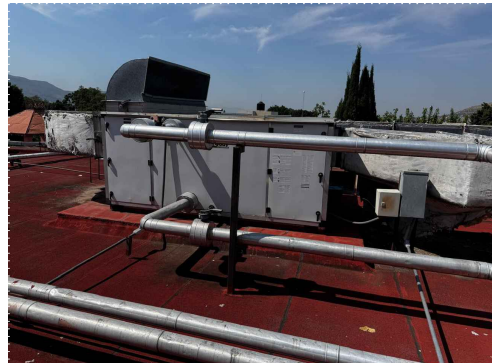
EA39. VISTA DESDE LA AZOTEA DEL TEATRO, DONDE SE OBSERVA UNO DE LOS EQUIPOS Y PARTE DE LA DUCTERÍA DE AIRE ACONDICIONADO.
