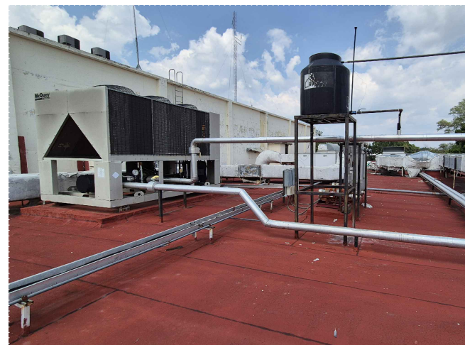
DL16. VISTA DE LA AZOTEA DEL TEATRO DESDE LA COLUMNANCIA PONIENTE HACIA LA PARTE ORIENTE, DONDE OBSERVAMOS LOS EQUIPOS, DUCTERÍA DE AIRE ACONDICIONADO Y EL IMPERMEABILIZANTE CON PRESENCIA DE CRAQUELADO Y DESGASTE DEBIDO A LA FALTA DE MANTENIMIENTO.
